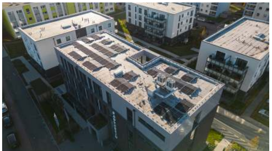
Photovoltaikanlage auf dem neuen Verwaltungsgebäude
