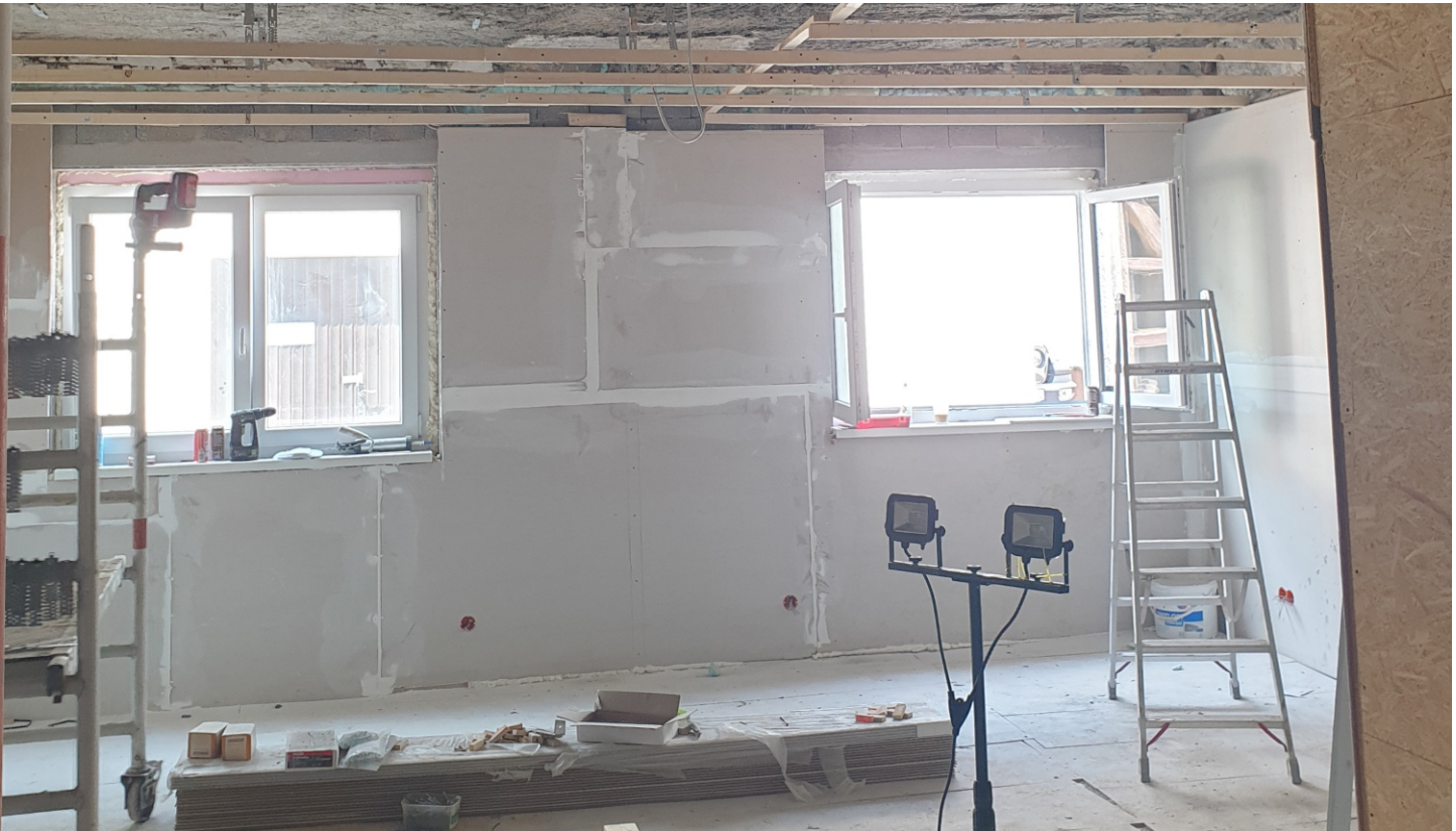
Wohnraum vor den Arbeiten
